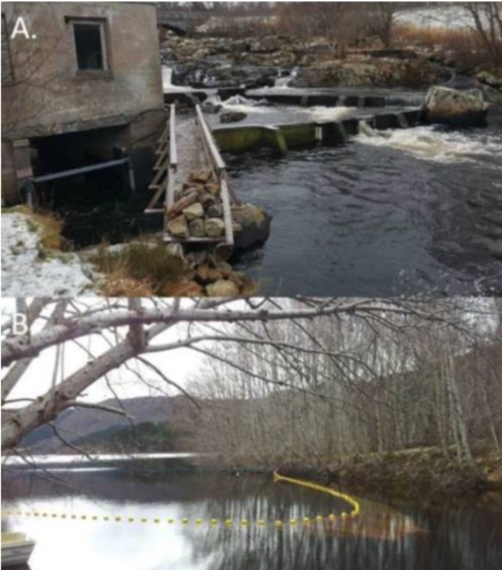
Figur 68. A) PIT-antenne vises som svarte rør montert på henholdsvis Kvernhuset (til venstre) og åpning i betongterskel (til høyre). Loggestasjonen er plassert inne i kvernhuset og er operative hele året. B) Elveruse for fangst av utvandrende fisk i utløpet av Vatnevatnet. (Fra Berntsen mfl. 2019b, bilder Marius Berg)
