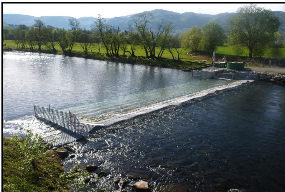
Figur 2. Konseptet byggjer på eit flyterist-modulsystem forankra i elvebotn oppstrøms, og skråstilt med straumretninga. Ristene er påmontert ein ”flaps” og fungerer som ei flyvenge. Jo raskare vasstraum, jo meir løft. Til høgre på bildet ser ein fangstkammeret.
