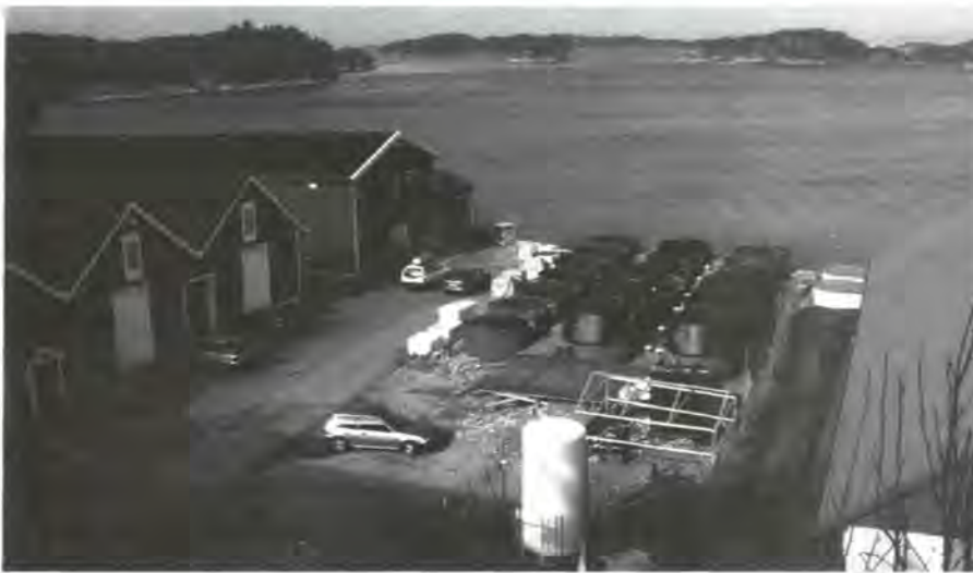
Figur 5.8 Deler av klekkeri, stamfisk- og forsøkshaller og andre forskningsfasiliteter på Sauaneset, Austevoll Havbruksstasjon. Parts of the hatchery, broodstock buildings and other facilities for halibut research at Austevoll Aquaculture Research Station.
