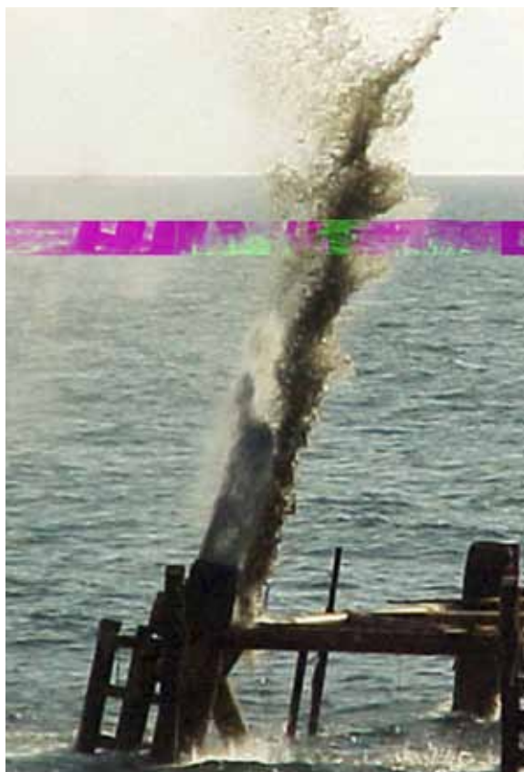
Figur 4. Fjerning av oljebrenntårn til havs med sprengstoff (© MMS, US Dept. Int.)
