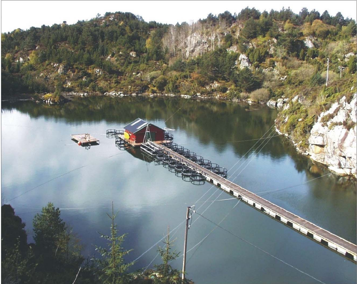
Figur 1. Svartatjern er ca 20 000m 3 stor, med største dyp på ca 3m. Pollen er et tidligere ferskvann som i 1984 ble erstattet med sjøvann ved hjelp av en pumpestasjon. Midt i bildet ses flåten med hus og filtersystem.
