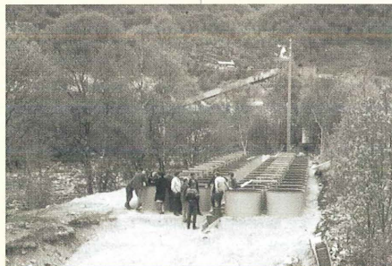
Byggingen er igang: Her skal forsøkshall 1 bygges, forsøkskarene er alt på plass
