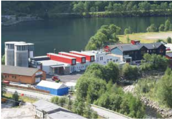
Forskningsstasjonen Matre etter modernisering i 2006.
