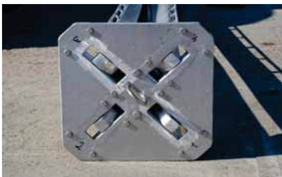
Figur 2. Sentrum i bunnramma danner fundament og ledd til de diagonale armene som spenner ut trampolinebunnen. Detaljene kring opphengsling av armar i senter av merdbotn er forstørret, og gis også i bilde 1. Konstruksjonstegninger kan fåes ved å kontakte Roar Skeide, Havforskningsinstituttet.
