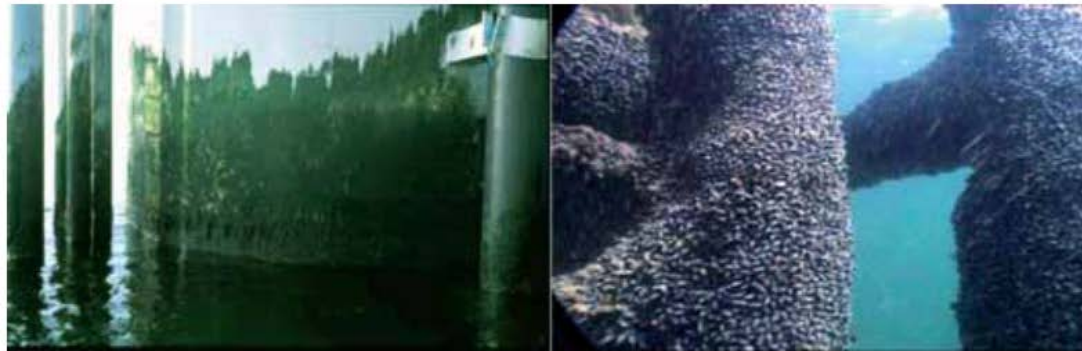
Figur 4. Påslag av grønnalger (til venstre) og blåskjell (til høyre) på vindturbinfundamenter ved Horns Rev vindpark, utenfor Danmarks vestkyst, omtrent ett år etter at turbinfundamentene ble utplassert. Green algae (left) and mussels (right) on wind turbine foundations at Horns Rev wind farm, off the west coast of Denmark, around one year after the foundations were installed. Kilde/source: Leonhard & Pedersen 2004. ( http://www.hornsrev.dk/Miljoeforhold/miljoerapporter/POST-CONSTRUCTION-Annual%20Report-2003-Hardbottom.pdf ).
