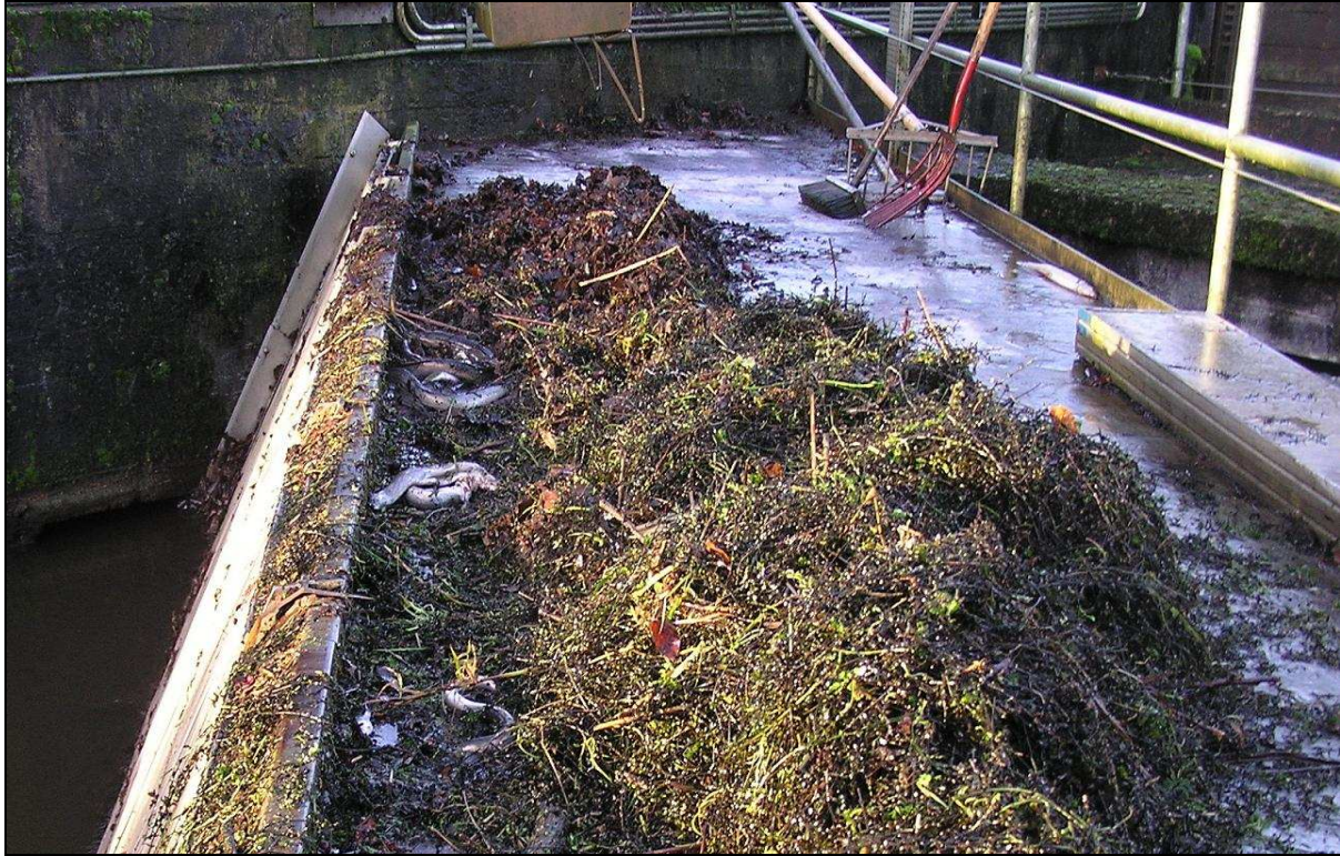
Figur 8-2: Ål som er fanget i rist på vannkraftstasjon i Danmark 2006. Foto: Michael Ingemann Pedersen Kilde: DTU Aqua, 2008
