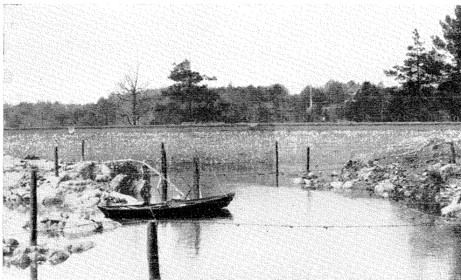
Fig. 11. Østersbassenget under uttapping mai 1941.
